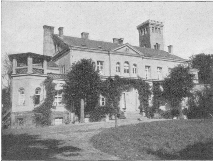
In der Siedlung Kraach soll das Gutshaus als Schule Verwendung finden.
