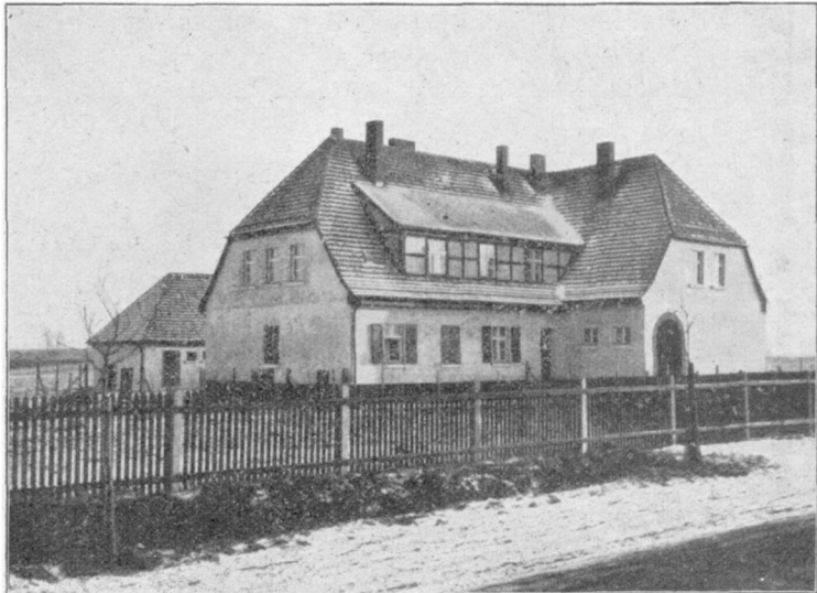
Die Siedlung Görlich hat eine neue Schule erhalten. Erbaut 1930.
