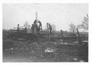
Abiperrung ber erften Durchbruchftelle im Stromwall burch Schlagen einer Spundwand, Blidrichtung fenfrecht gum Strom.
