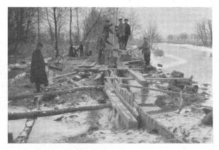
Absperrung der ersten Durchbruchstelle im Stromwall durch Schlagen einer Spund-Phot. Ebeling. wand, Blidrichtung parallel zum Strom.
