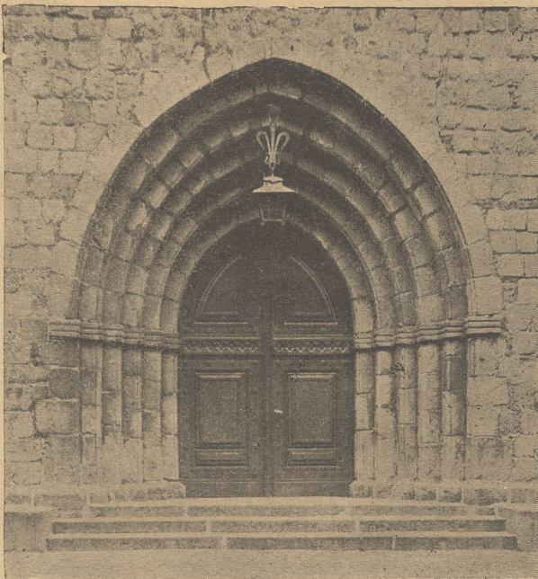
Bortal der Marienkirche zu Prenzlau.
