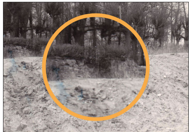
Bild 13 Die Mauer ca. 1970. Links in Originalhöhe, daneben Kriegszerstörungen. Darüber die wuchernde Hecke. Ganz rechts im Kreis kann man erahnen, wie wenig sie über das Bodenareal des Laubenganges hinaus ragte.
