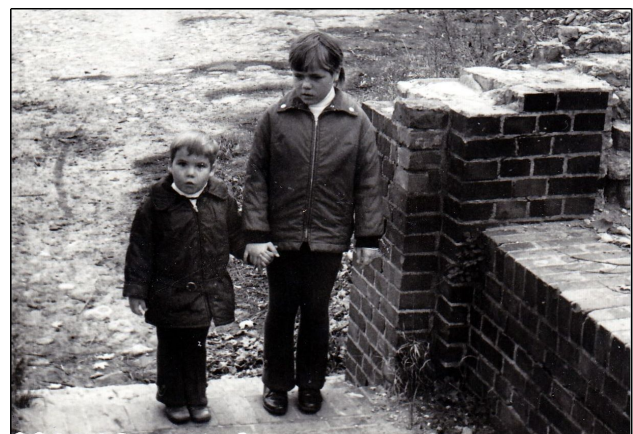
Bild 14 Hier stehen meine Schwester und ich im Tor vor der Südbastion. (siehe Bild 7) Dieses Tor wurde nachträglich in die Mauer eingesetzt.
