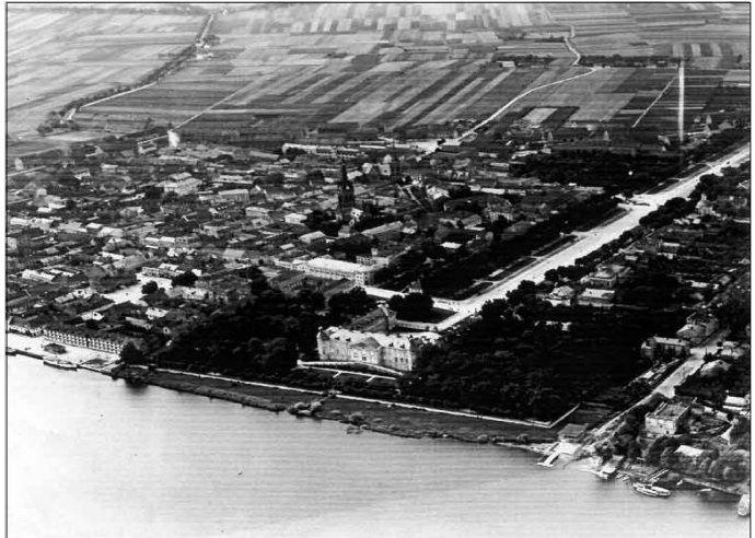
Bild 3: Luftaufnahme von Norden: als weißes Band zieht sich die Mauer um den Schloßgarten
