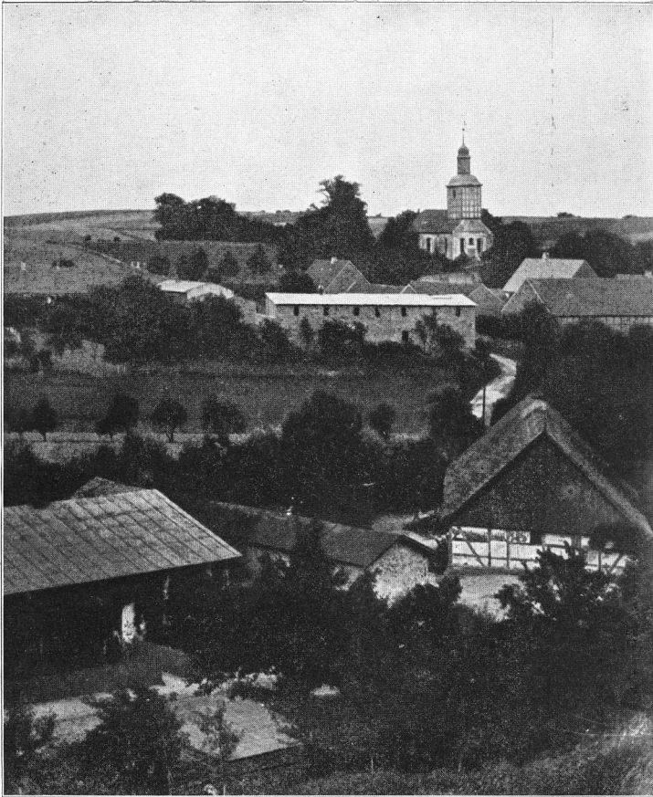
Nr. 1. Stolzenhagen (M.) . Ein gutes Beispiel für die das Dorf überragende Stellung der Kirche. Das Dorf selbst liegt in einer Schlucht, die von Westen nach Osten zur Oder herabfällt. Der Kirche gegenüber liegt auf einem künstlichen Plateau das Herrenhaus, ein großer, geräumiger Raften, zirka 1750 erbaut. Der aus dem 18. Jahrhundert stammende Turm ist dem Schiff auf der Mitte der Südseite vorgelagert. Ein hübsches Bild der Kirche von Westen findet sich bei N. Nielke (Unsere Dorfkirche S. 69), der aber diesen merkwürdigen Bau aus eigener Anschauung offenbar nicht kennen gelernt hat.
