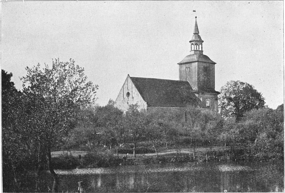
Nr. 2. Gordenbeck (L.) Die im 30jährigen Kriege zerstörte Kirche ist im Anfang des 18. Jahrhunderts neu aufgebaut. Der Ostgiebel alt, aber nicht in seiner einstigen Höhe wiederhergestellt, was die verstümmelten Blendfenster beweisen.
