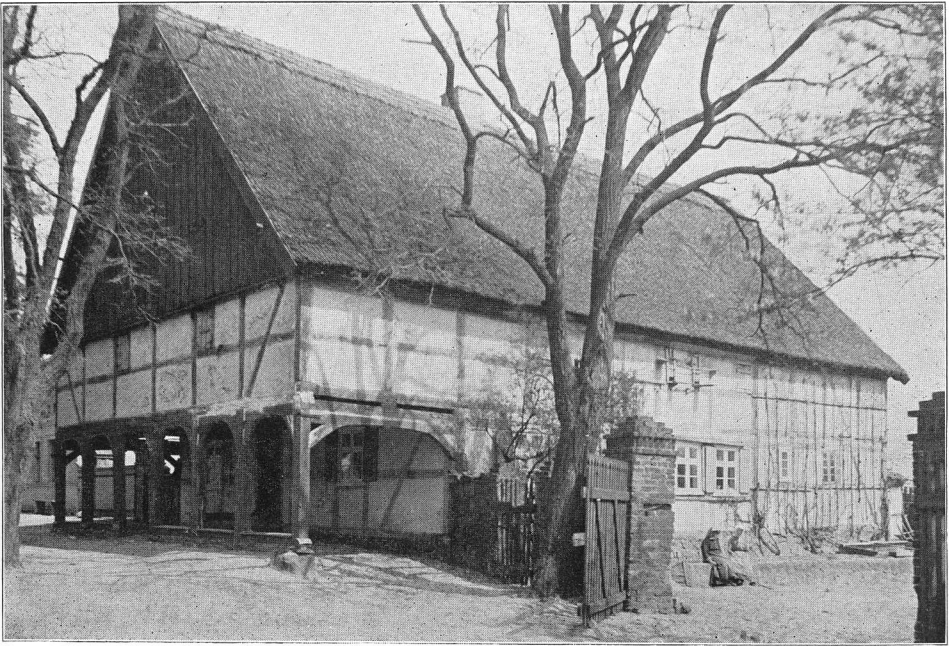
Nr. 5. Laubenhaus aus Lüdersdorf, die beiden hintersten Fenster bilden einen jüngeren Anbau.
