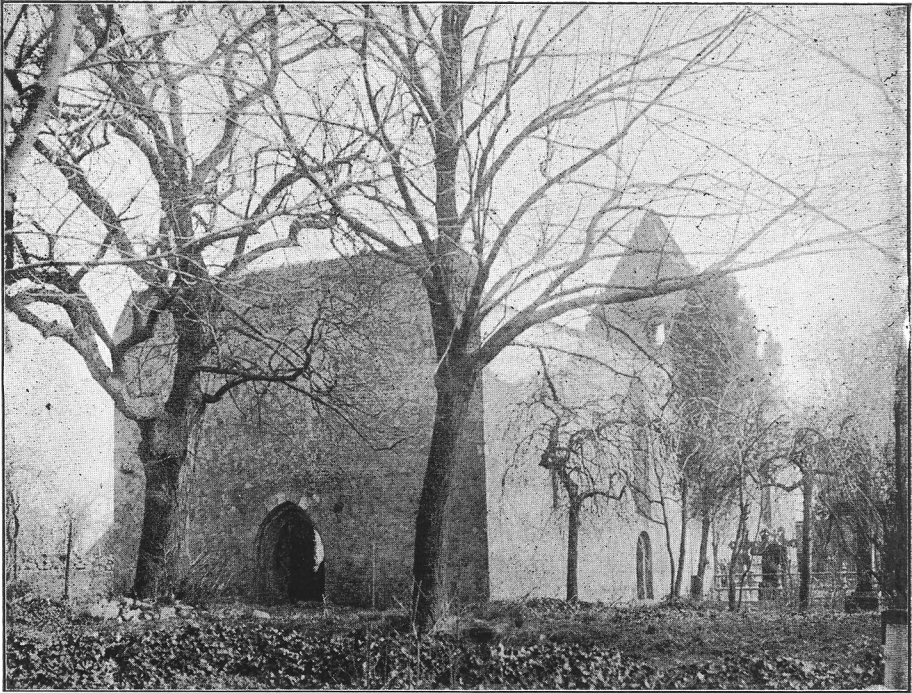
Abb. 1. Das ausgebrannte Kirchengebäude in Wiesenbrom.
