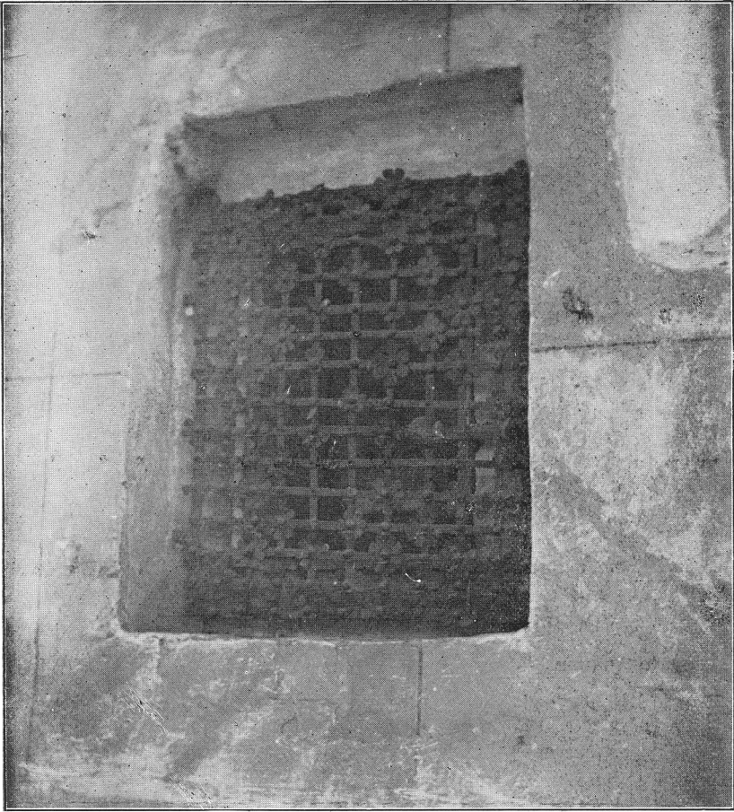
Abb. 7. Nische mit Gittertür in der östlichen Wand der Kirche in Biesenbrow.
