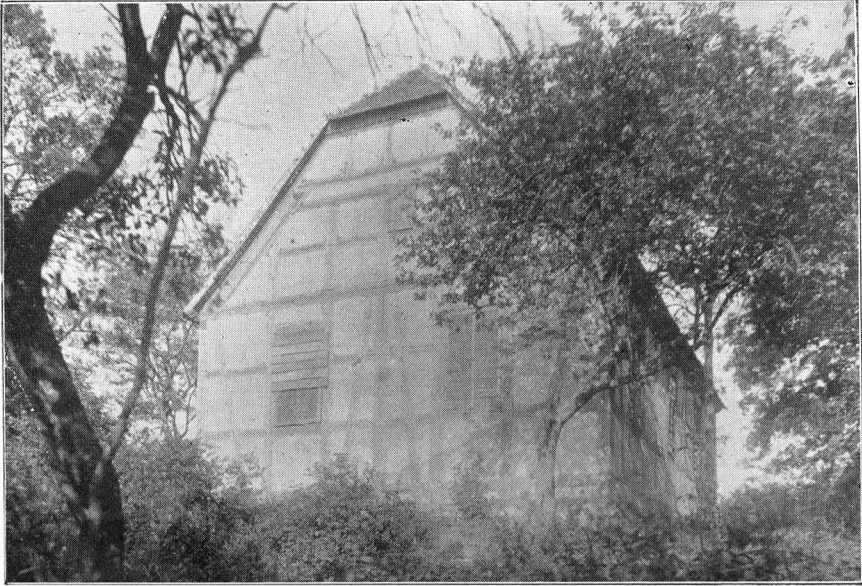
Blankensee, Fachwerkkirche, Gesamtansicht.
