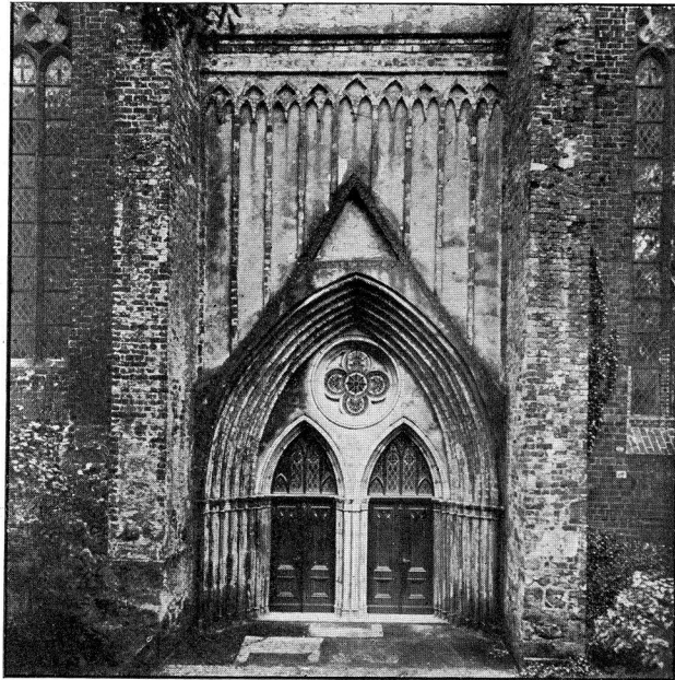
Nordportal der jetzigen Nikolai-, einstigen Dominikanerkirche zum h. Kreuz. Nach einer Aufnahme der Kgl. Meßbildanstalt von 1902.
